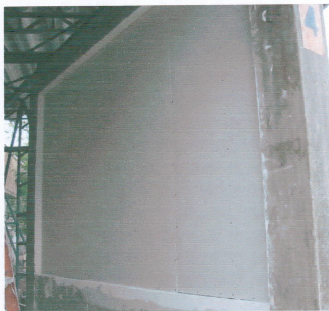
Foto 6: Instalação das chapas de gesso acartonado
