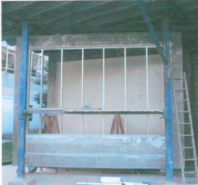
Foto 1: Estrutura metálica montada no vão do pórtico de concreto
