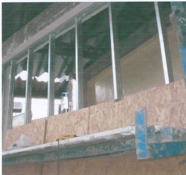
Foto 3: Instalação das chapas de OSB na estrutura metálica
