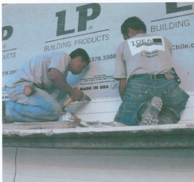
Foto 5: Detalhe da fixação do siding sobre a membrana hidrófuga.
