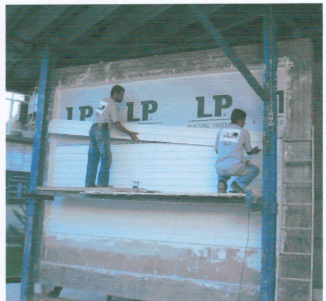
Foto 4: Fixação das régulas de siding sobre a membrana hidrófuga
