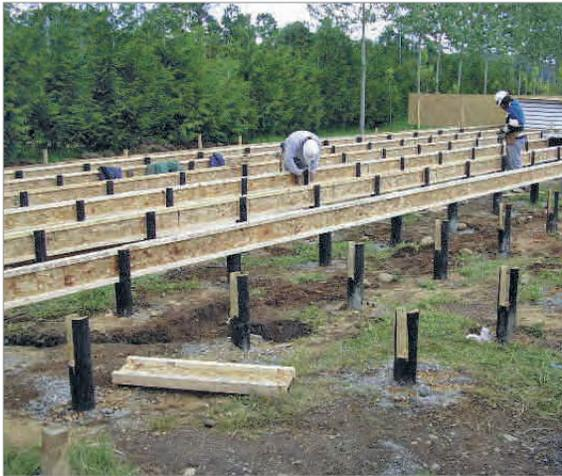
con dos **clavos lanceros** sobre cada apoyo; se debe chequear constantemente el paralelismo de las vigas secundarias. Al concluir la instalación de las vigas secundarias y con el fin de evitar el volcamiento o efecto dominó de éstas, se aplica una tapa uniendo la cabeza de las vigas.
