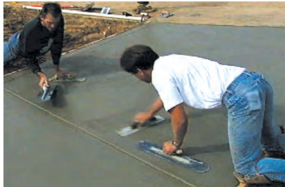
En grandes superficies es aconsejable utilizar equipos de alto rendimiento, tanto para el regleado como platachado, utilizando cerchas vibradoras y helicópteros de afinado.
