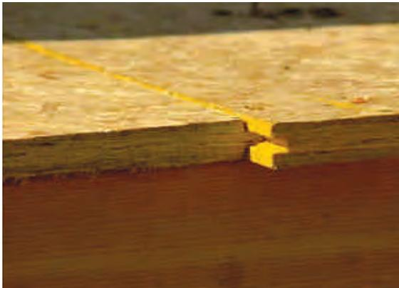
A medida que se instalan tableros, se deben trazar las vigas principales y secundarias, lo que asegura que la fijación en el centro de los tableros impacte en las vigas y no queden en el aire.
