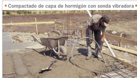
Se debe evitar que el **vibrador** de inmersión entre en contacto con la malla o enfierradura.
