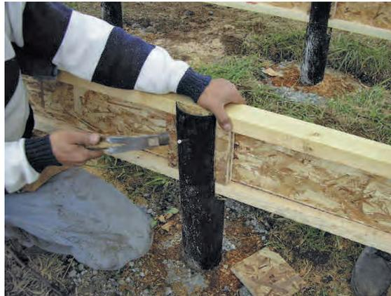
Una variante a la plataforma explicada se obtiene mediante el **envigado** entre las vigas maestras: dependiendo de la solución constructiva, las vigas maestras podrán ser parte de la plataforma al ubicarse en el mismo plano que el de las vigas secundarias.
